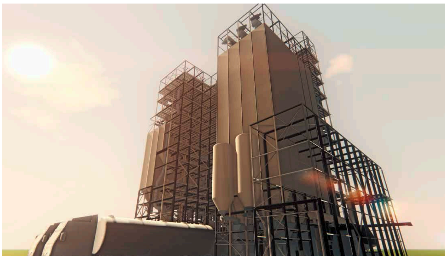
Mischfutterwerk der Firma Rothkötter.
