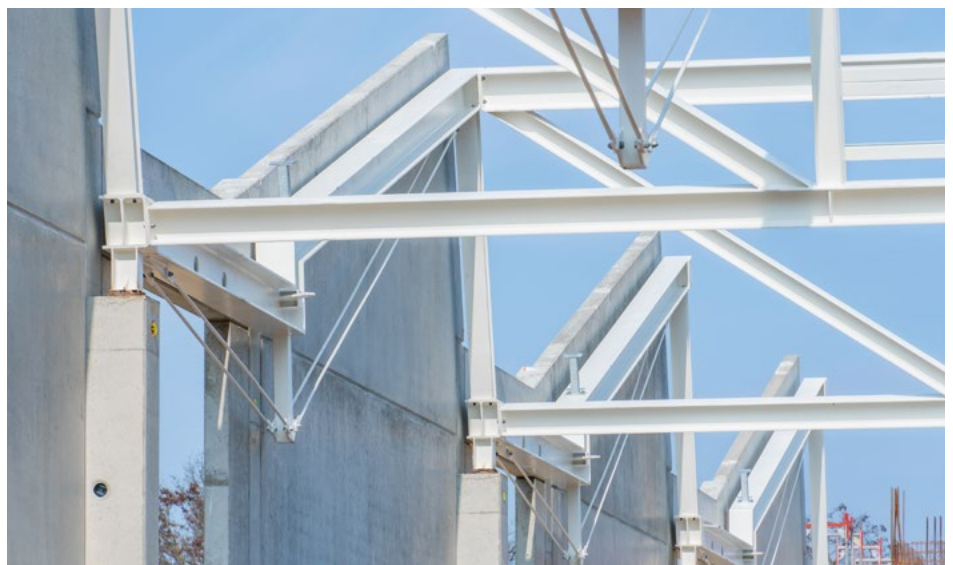
Das Dachtragwerk ist ein besonderer Kunstgriff.
