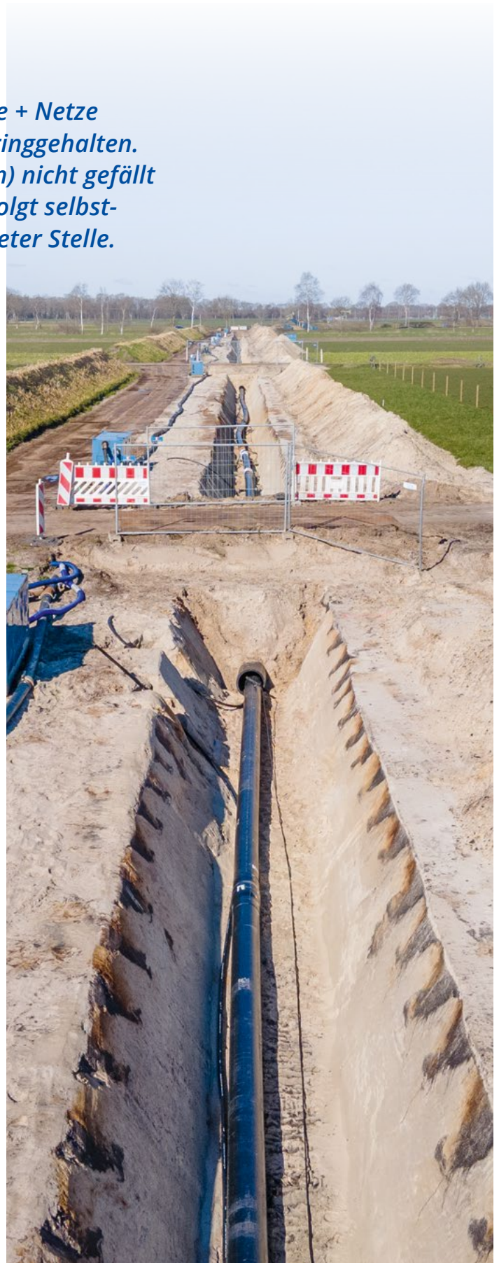
Die Rohre werden mit einer Mindestüberdeckung von 1,20 m verlegt.
