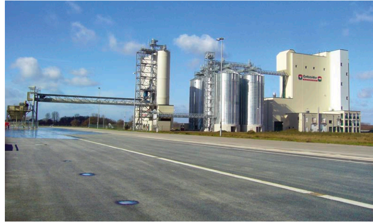
Die LINDSCHULTE Ingenieurgesellschaft mbH Emsland hat unter anderem die Generalplanung für die Futtermittelumschlaganlage sowie das Kraftfutterwerk der Fa. Rothkötter im Industrie-Euro-Hafen in Haren-Meppen übernommen.
