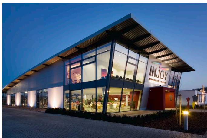
Moderne Architektur, hohe Funktionalität: Auch für das Injoy Gesundheits- und Fitnesscenter in Nordhorn war LINDSCHULTE Generalplaner.
