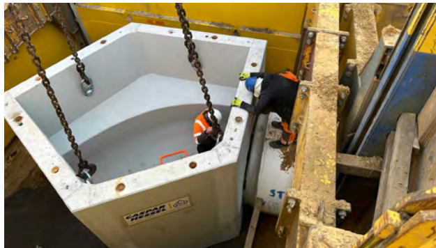
Einbau Fertigteilschacht RW 500
