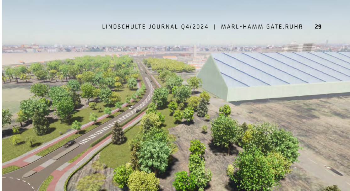
Erschließung ehemaliger Zechenflächen
