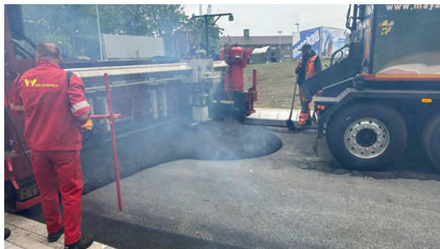
Einbau Gussasphalt Kreisverkehr Süd
