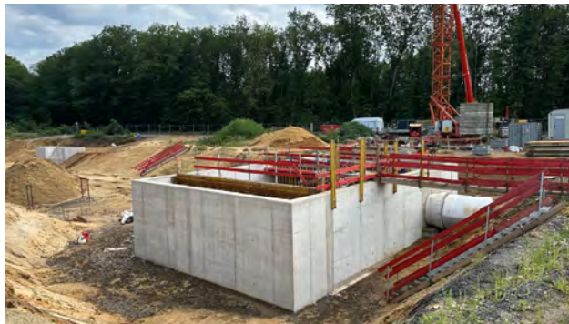
Rohbauarbeiten Regenklärbecken und Drosselbauwerk Nord
