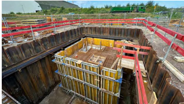
Baugrubenverbau und Rohbauarbeiten Schmutzwasserpumpwerk
