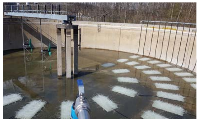
Prüfung Umbau Belebungsbecken
