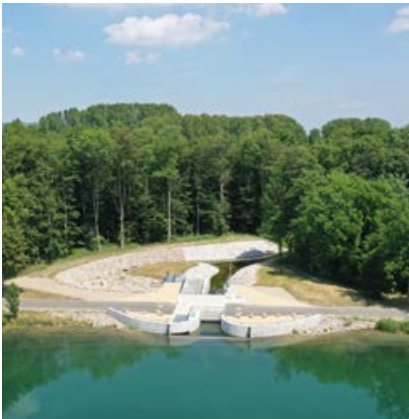
Einlaufbauwerk Polder Breisach
