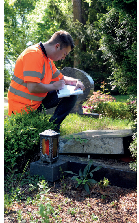
Maximilian Vages bei der Arbeit: Diesen Grabstein musste er vorsichtshalber niederlegen, da Unfallgefahr bestand. Der Anschluss an die Bodenplatte war nicht in Ordnung. Foto: ©Isabella Raupold
